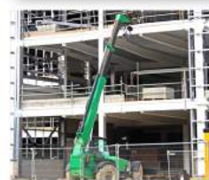
Non Slewing Crane
